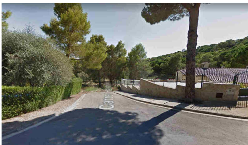
Tram de carrer Heemstede que s'adequarà dins de les obres d'urbanització.
