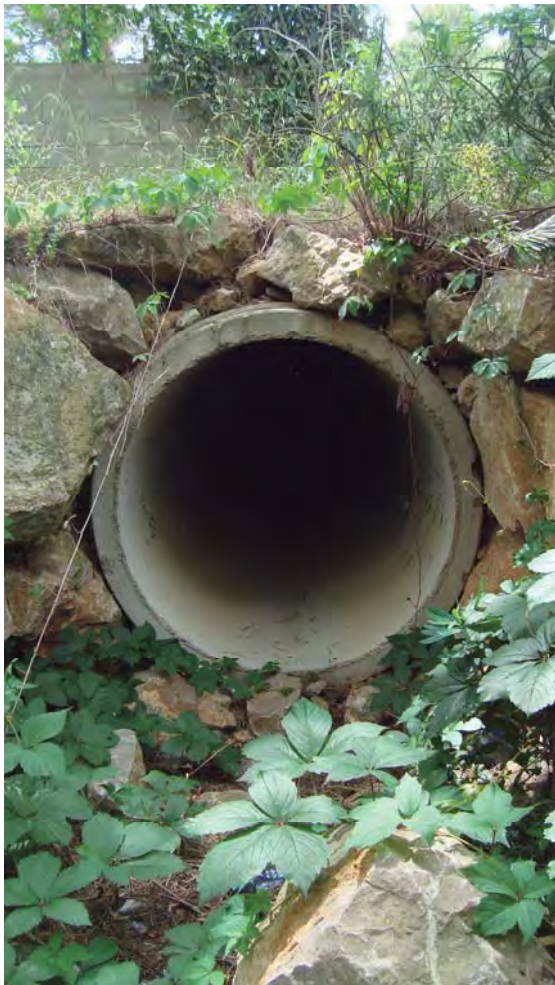
Final de la canalització
