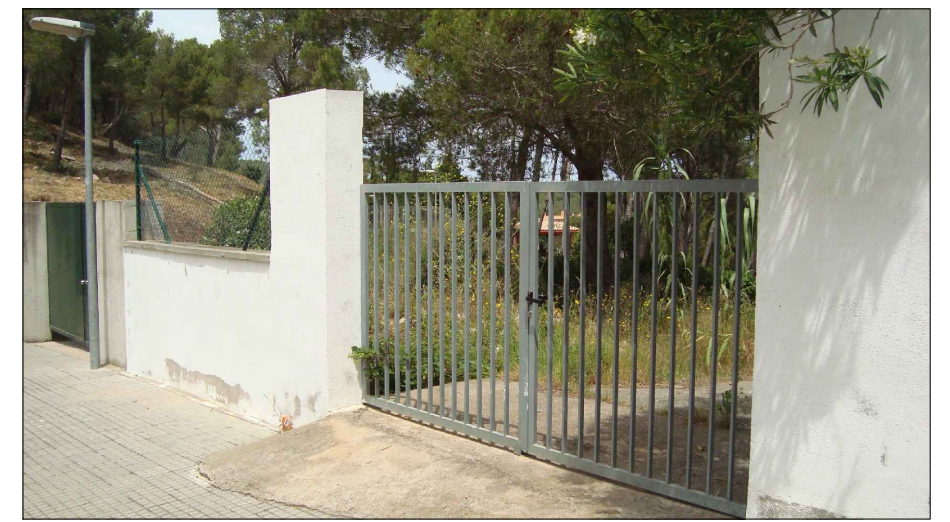
VISTA 1: PORTA ACCÉS A CAMÍ RURAL EXISTENT
