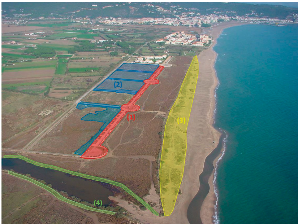
Figura 3. Principals actuacions de la restauració de la Pletera. (1) Retirada de l'escullera i el passeig; (2) retirada dels carrers d'accés i recuperació del nivell topogràfic de la maresma; (3) restauració del sistema dunar; (4) retirada de les motes artificials per facilitar el desbordament de les llacunes. Foto: Bon Vent de l'Empordà.
