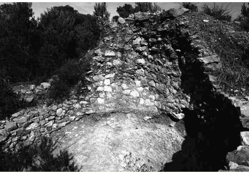
▲ Forn de calç de Sta. Caterina.
