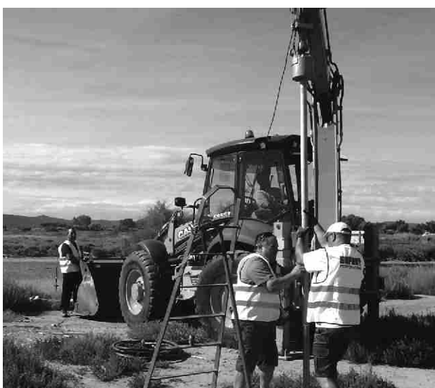
▲ S'han instal·lat sondes de temperatura, salinitat, oxigen i nivell a les Basses d'en Coll, Ter Vell, la Pletera i al Rec de Sentmenat
