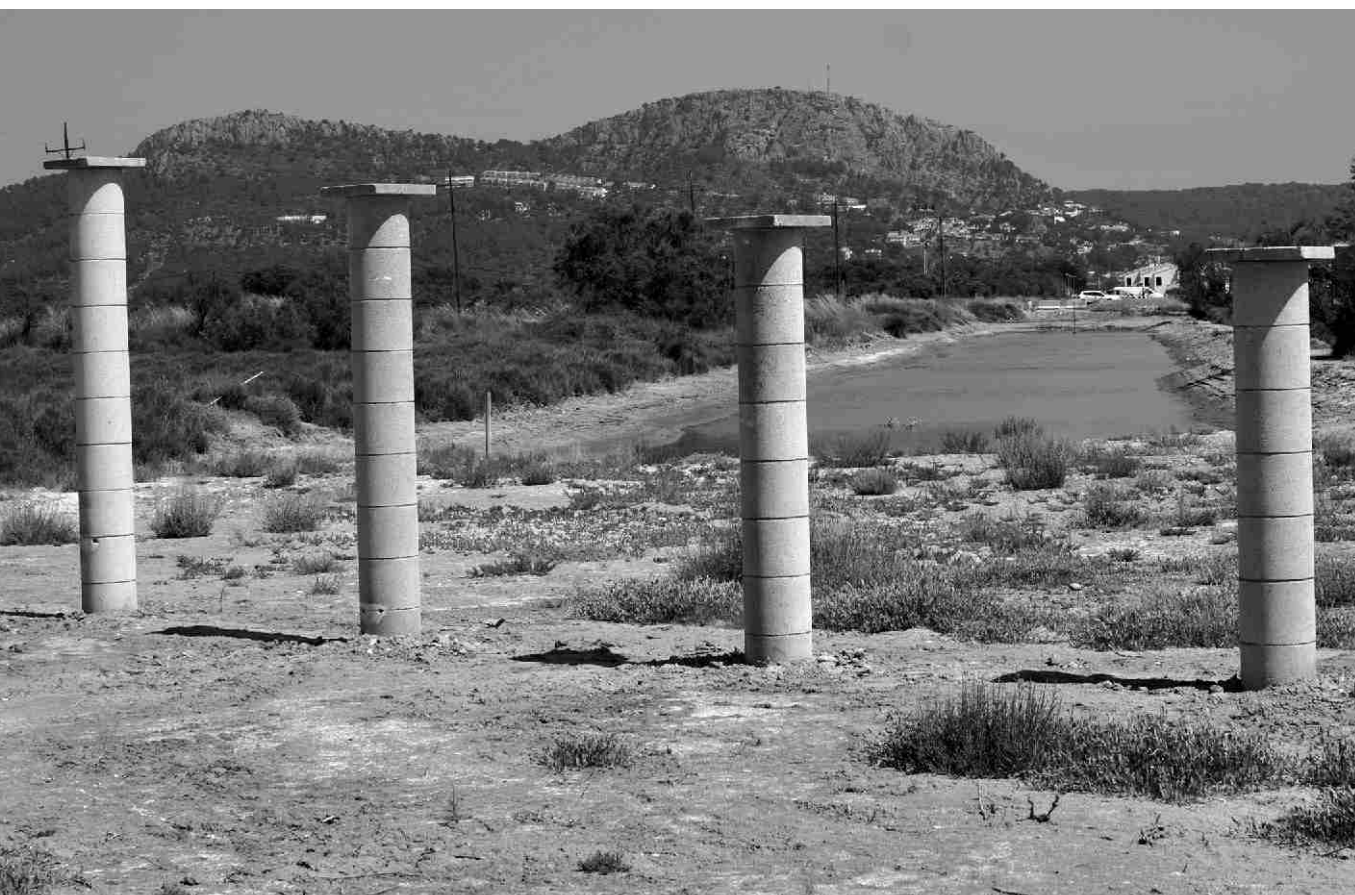
▲ En el marc del projecte Lloc, memòria i salicòrnies, l'artista torroellenc Joan Vinyes ha construït una ruïna mitjançant una sèrie de columnes procedents de l'enderroc de les rotondes de l'antic passeig.
