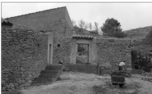
Detall dels treballs que està realitzant la Brigada Municipal.
