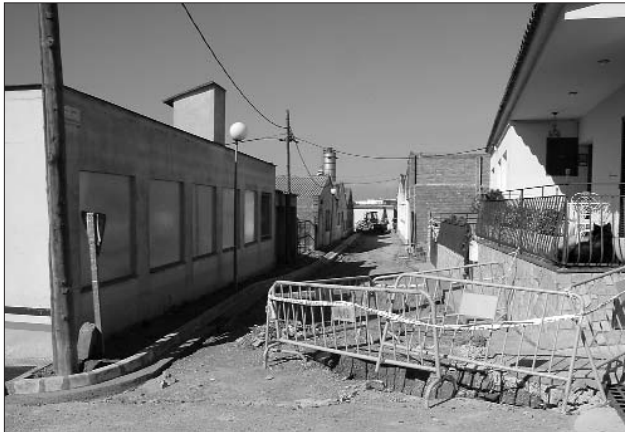
Treballs al carrer Ramon Dalmau de Torroella
