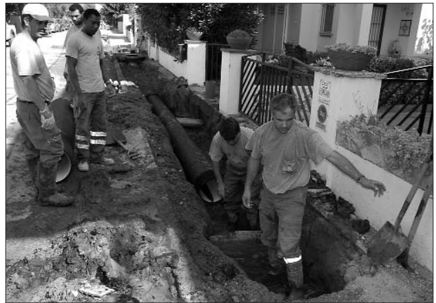
Operaris de la Brigada Municipal, treballant al carrer Dàlia
