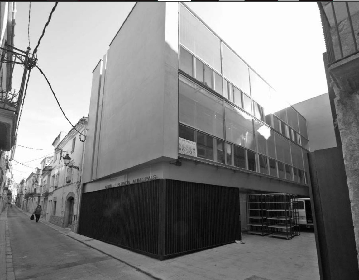
El nou edifici de serveis del carrer Hospital acollirà l'Arxiu Municipal, Medi Ambient, Serveis Tècnics i Promoció Econòmica.
